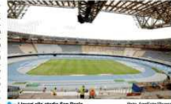
I lavori allo stadio San Paolo (foto Agrofot/Verona)
